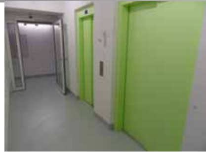
2 Lifte, barrierefreier Zugang zu Einstellhalle, Keller 16 m 2 mit Metallgestellen
