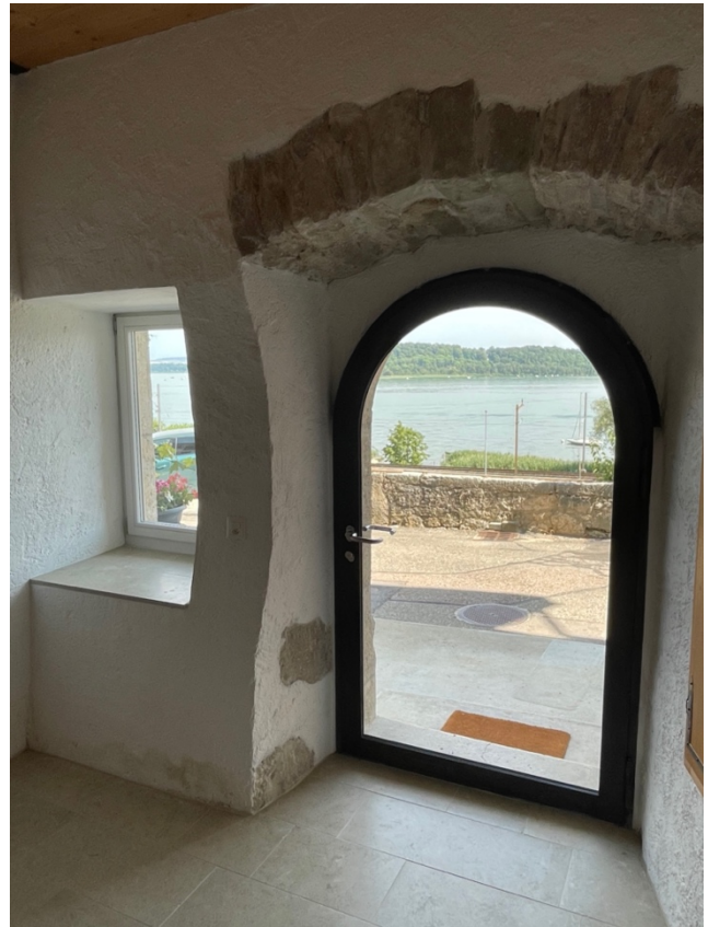
Eingangsbereich, Blick Richtung See
