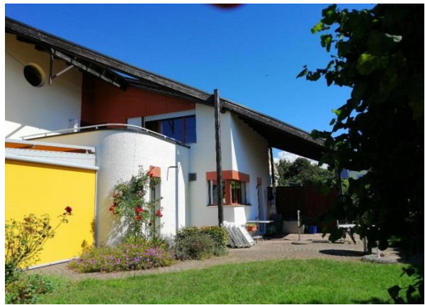
Ansicht von Süden mit Sitzplatz, Balkon und Wintergarten (links gelber Sonnenschutz)
