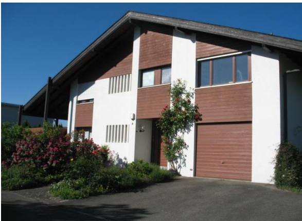
Ansicht von Zufahrtstrasse mit Hauseingang, Abstellplätzen und Garage
