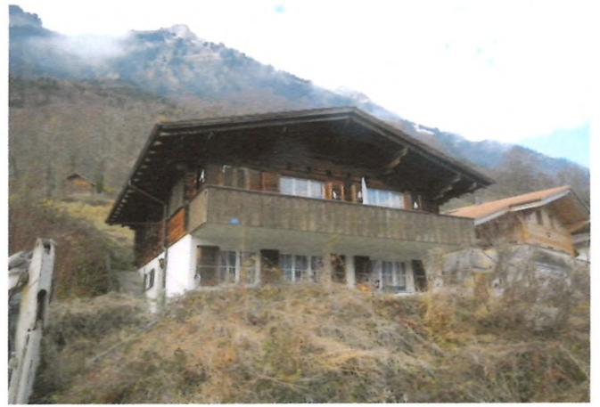
Fassade Südwest und Südost
