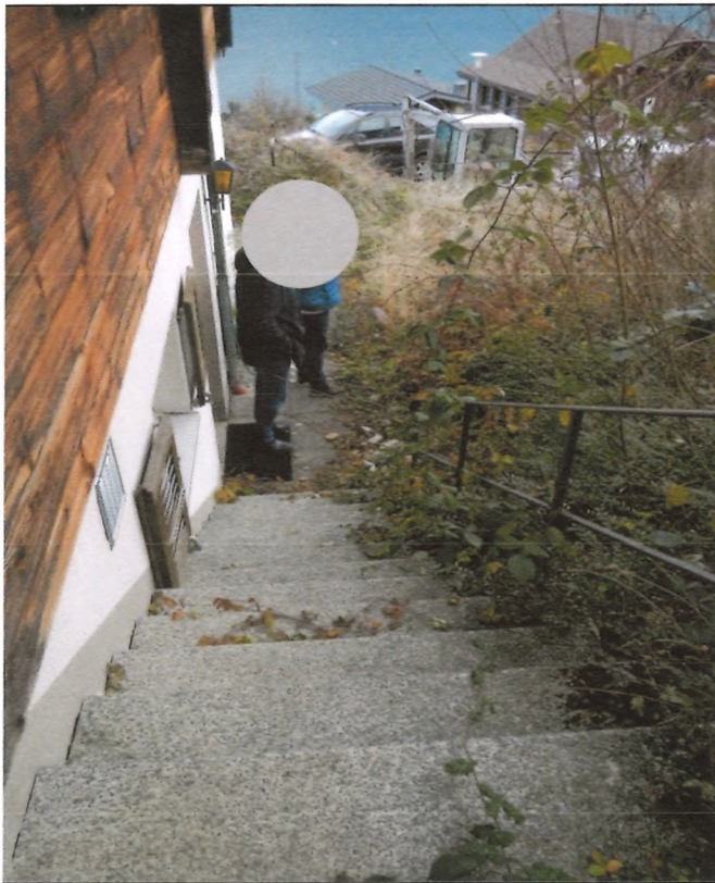
Treppe West zu Wohnung OG
