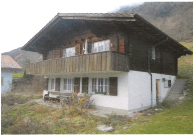
Fassade Südost und Nordost
