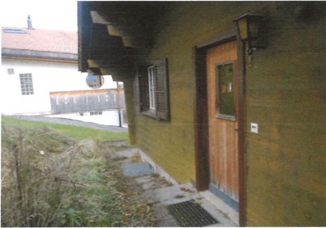
Eingang zu Wohnung OG Nordwestfassade
