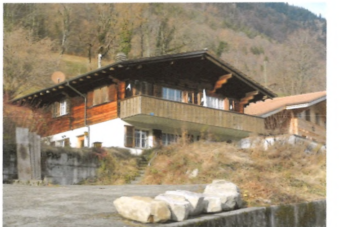
Fassade Südwest und Südost, Zugangstreppe ab Parkplatz
