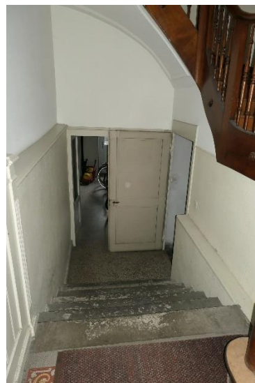
Treppe zu UG
