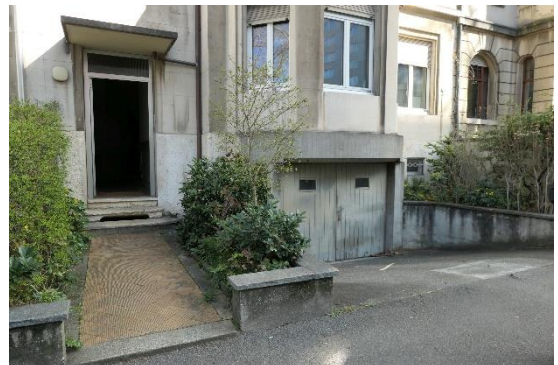
Eingangsbereich mit Garagenabfahrt
