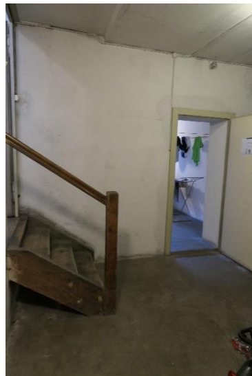
weitere Treppe zu Vorplatz
