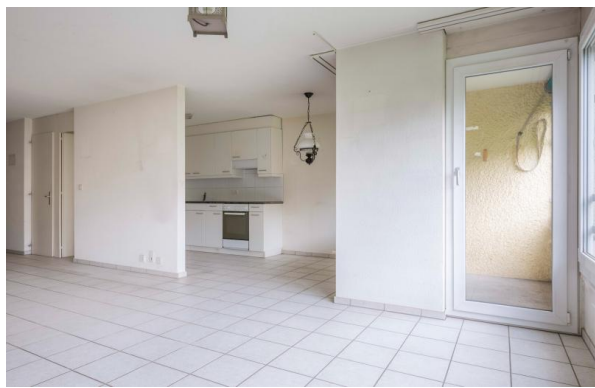
Wohnbereich mit Zugang Küche und Balkon – vor Sanierung Küche
