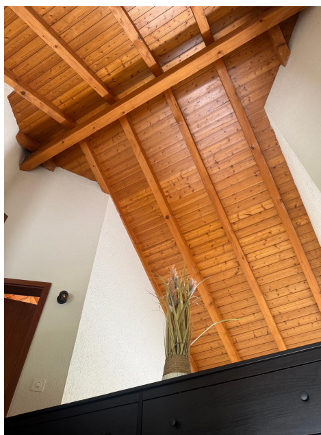
Le volume de 7 m et sa charpente, depuis l'étage
