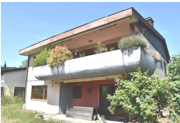
Südost-Ansicht mit gedecktem Sitzplatz
