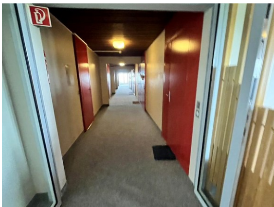
Etagenkorridor mit Zugang zu den Wohnungen
