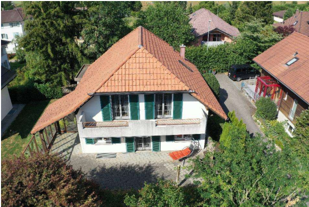
Fassade Süd – West
