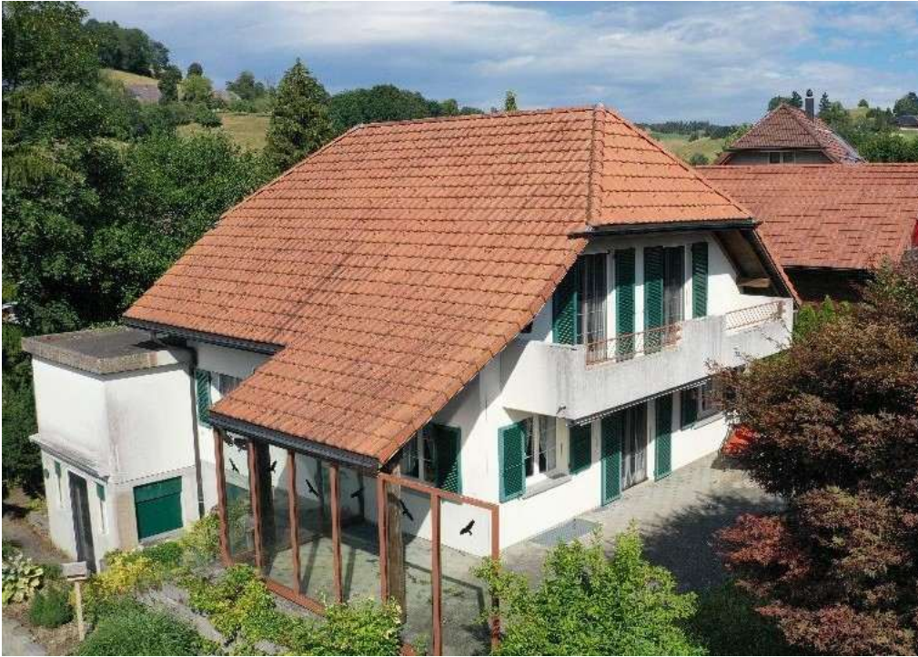
Westecke, gedeckter Sitzplatz, Aussentreppe zum Atelier im UG
