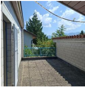
Dachbalkon und Reduit (7)
