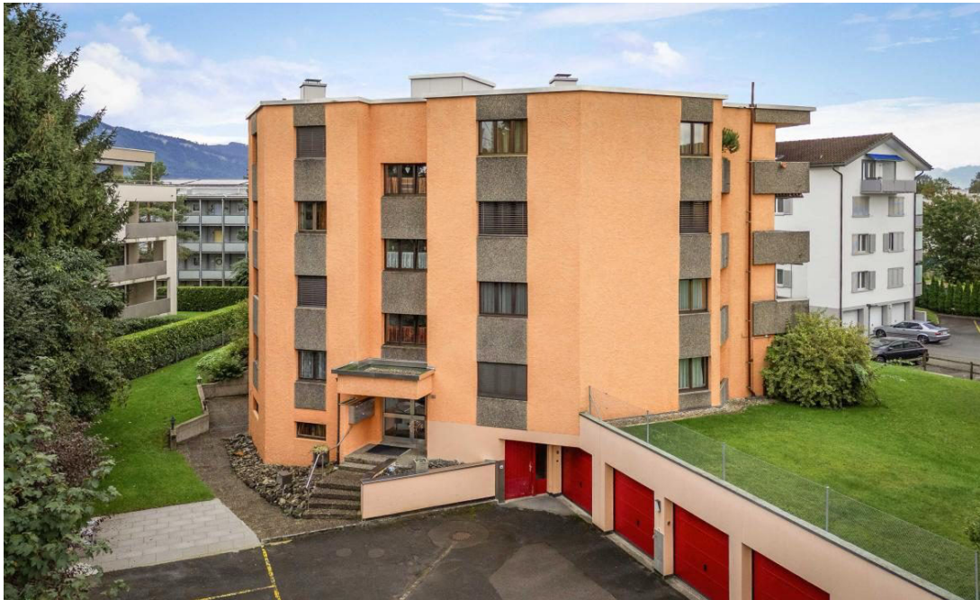
Zugang, Garagen und Vorplatz
