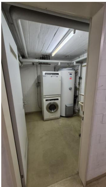
Kellerabteil mit Waschmaschine/Tumbler
