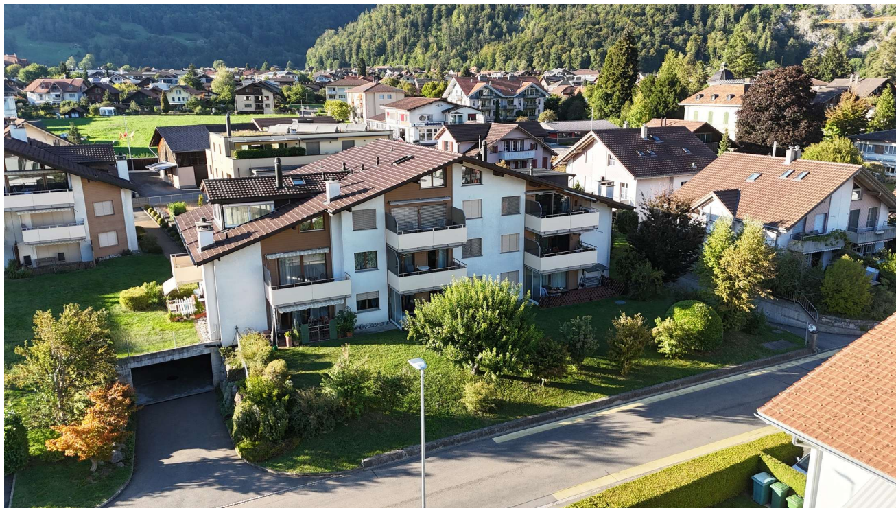
Aussenansicht der Liegenschaft
