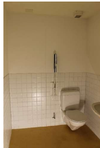
neutrale, behindertengerechte Sanitäranlagen
