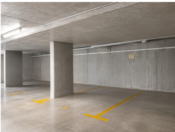
Autoeinstellplatz Nr. 5 in der Tiefgarage
