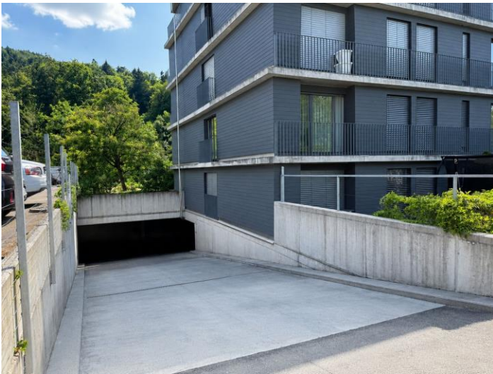
Einfahrt in die Tiefgarage
