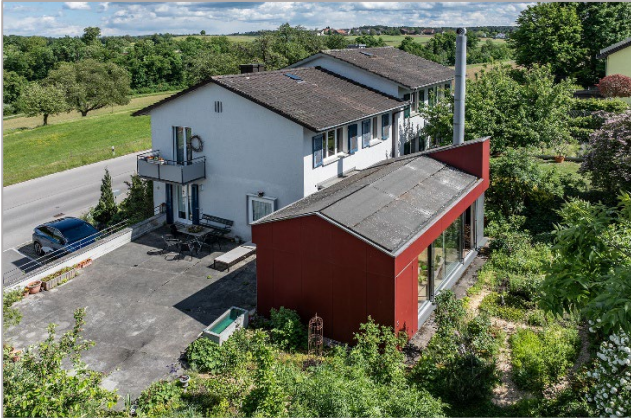
Blick von Nordwesten
