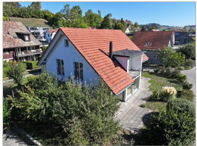
Blick von Südwest
