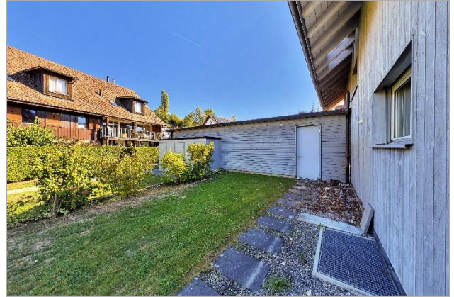
Nordseite (Blick zur Garage)
