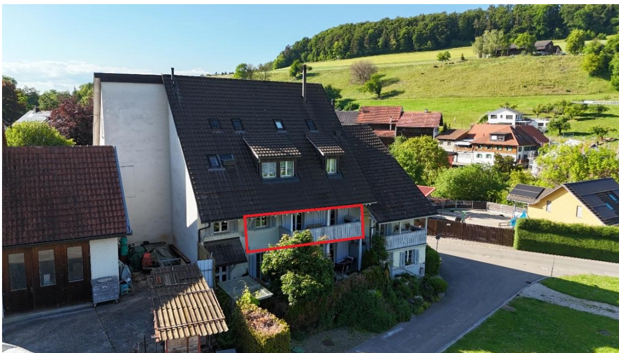
Aussenansicht mit kleinem Balkon
