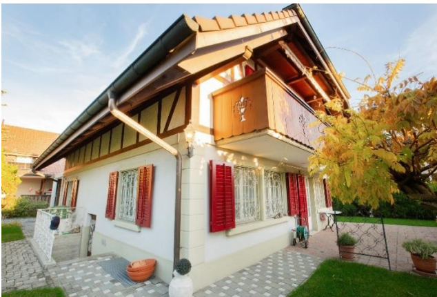
Ansicht von Westen
