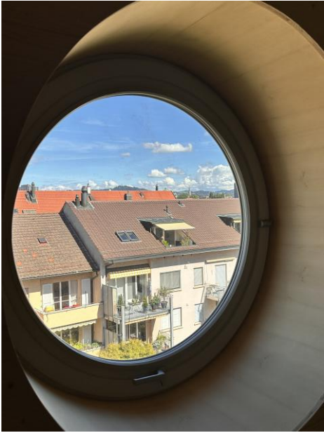
Seitliches Fenster Dachgeschoss
