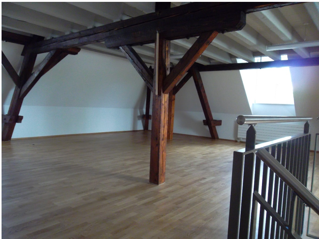
Grosszügige Flächen mit sichtbarer Holzkonstruktion und Lukarnen
