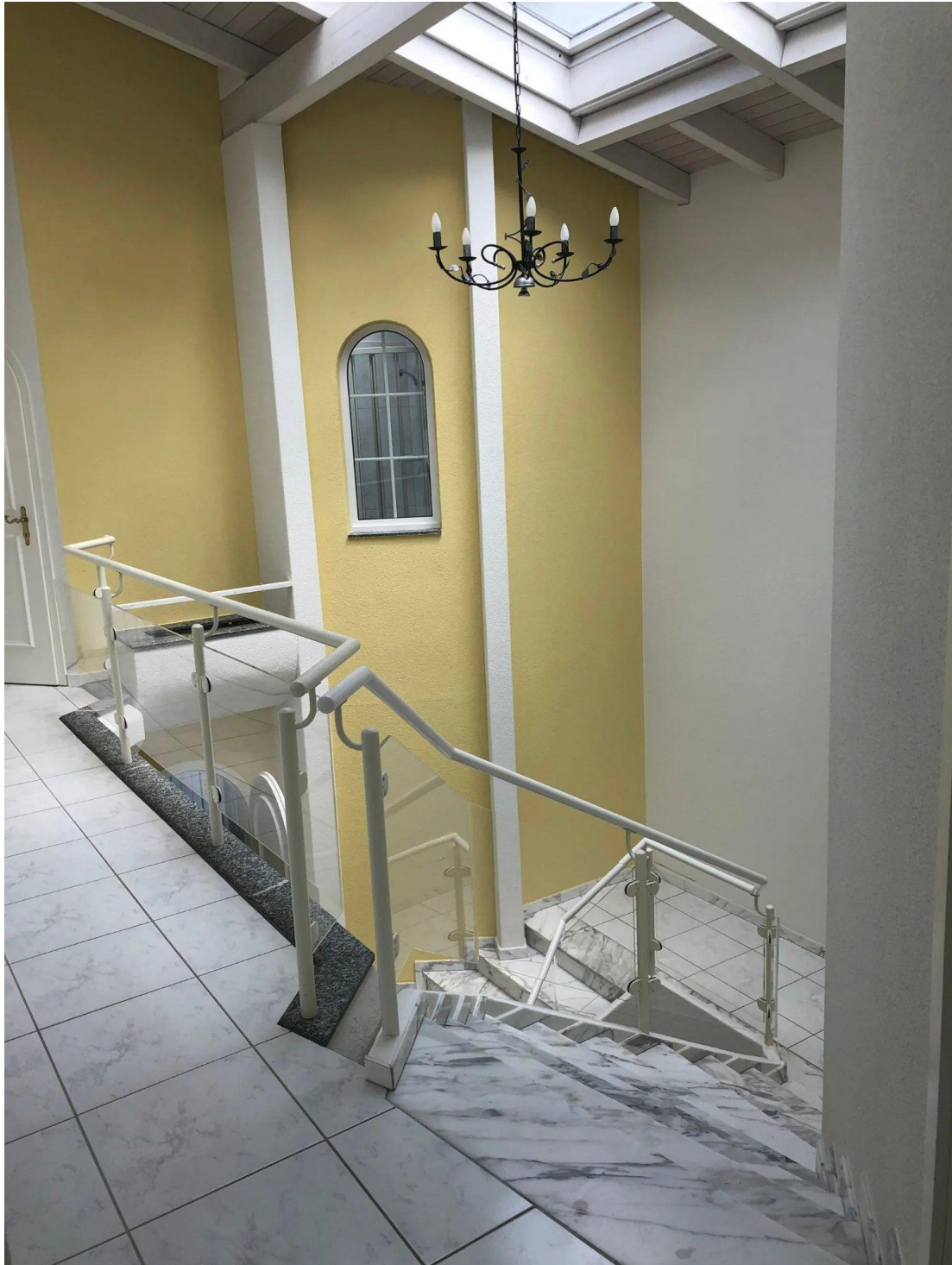
Offenes Treppenhaus mit Natursteinlauf, gläsernem Geländer und Tageslichteinfall.
