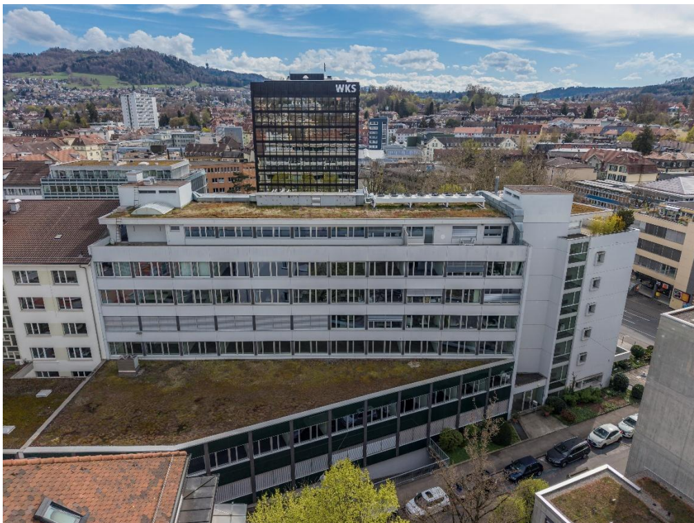
Nordfassade mit Blick nach Süden
