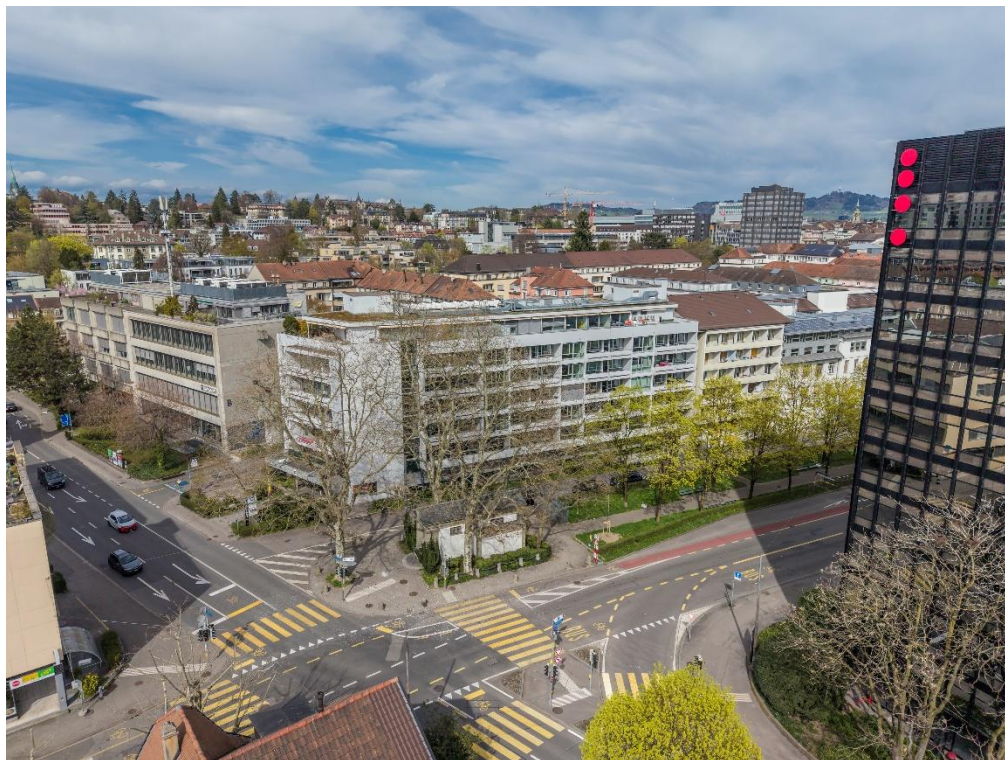
Südfassade mit Blick nach Norden
