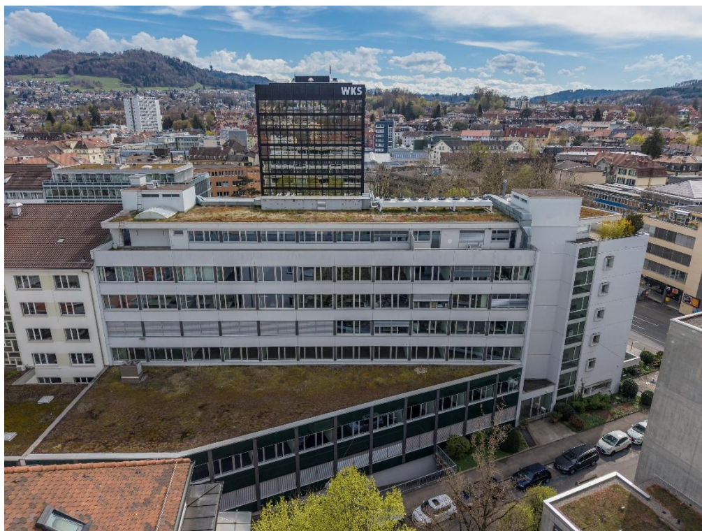
Nordfassade mit Blick nach Süden
