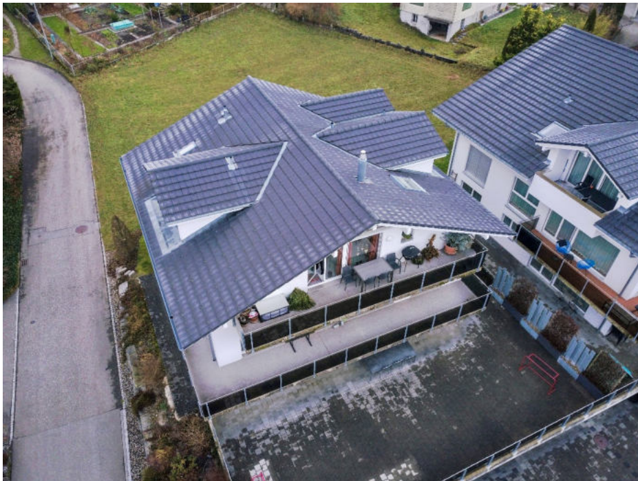
Wohnhaus Pappelweg 6a mit Unterunterständen
