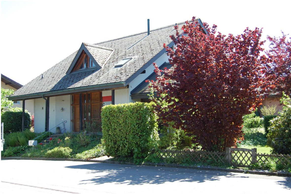
Ansicht Nord / Haupteingang
