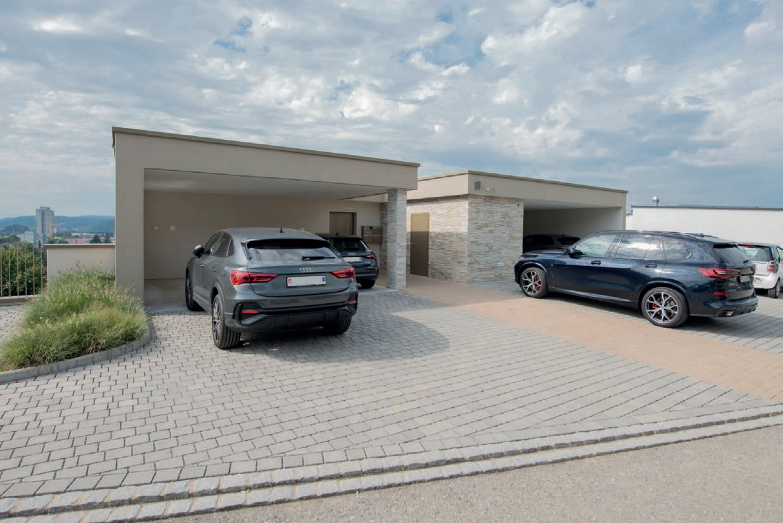
Haupteingang / Vorplatz zur Wohnung gehören 2 Parkplätze
