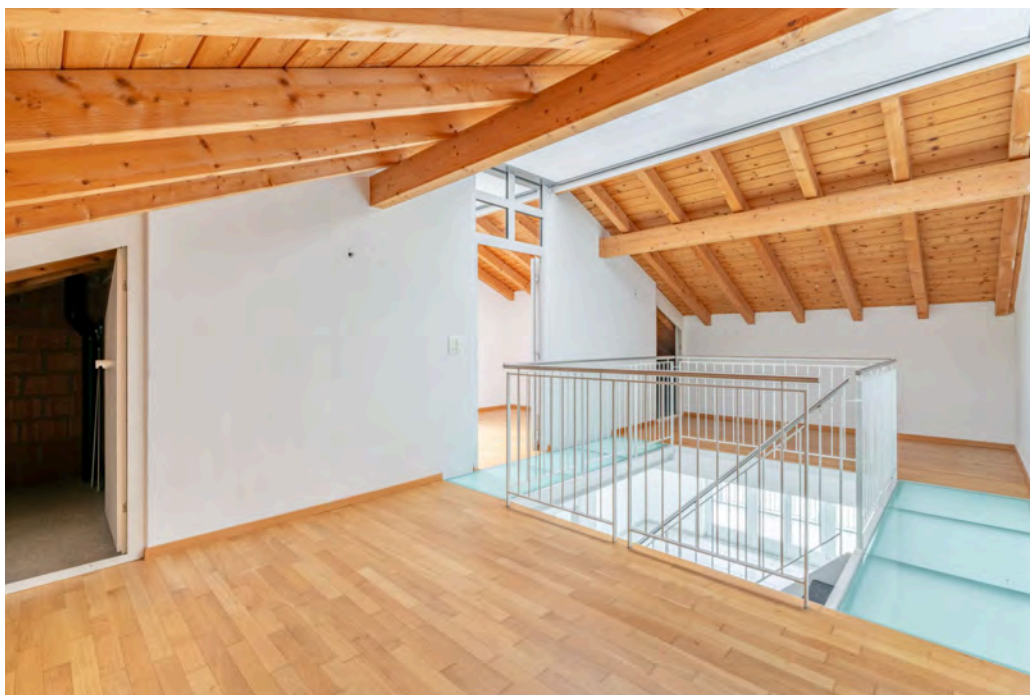
Galerie im Obergeschoss
