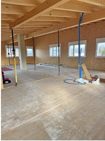
Obergeschoss – 134 m 2 im ausbaubaren Zustand
