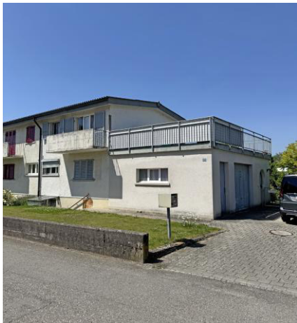
Frontansicht | Einfahrt Garage
