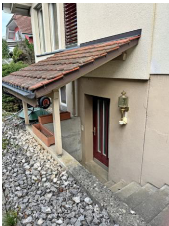
Separater Eingang zu den Kellerzimmer
