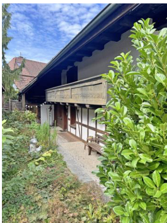
hinterer Hauszugang | Kellerabgang
