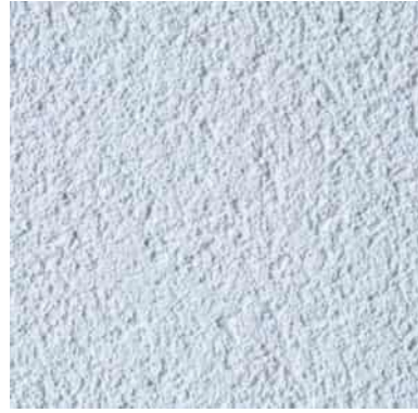
Fassaden Abrieb gestrichen
