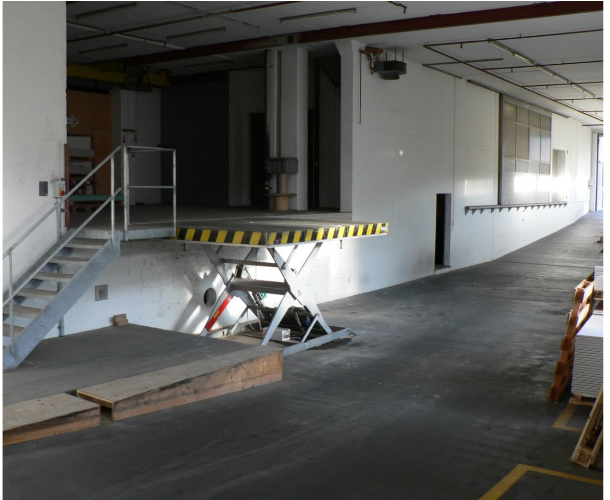
Anlieferung mit Hebebühne und Warenlift
