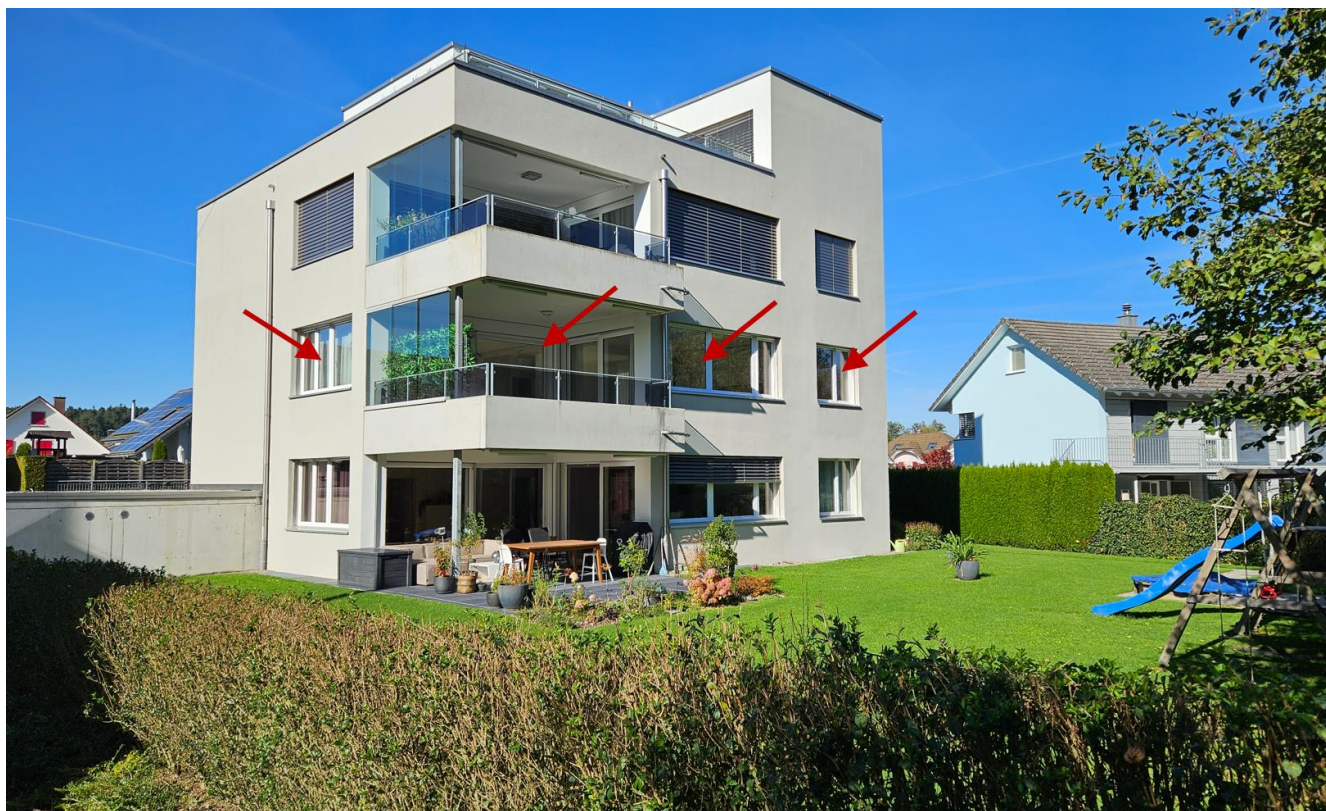
Mehrfamilienhaus von Süden
