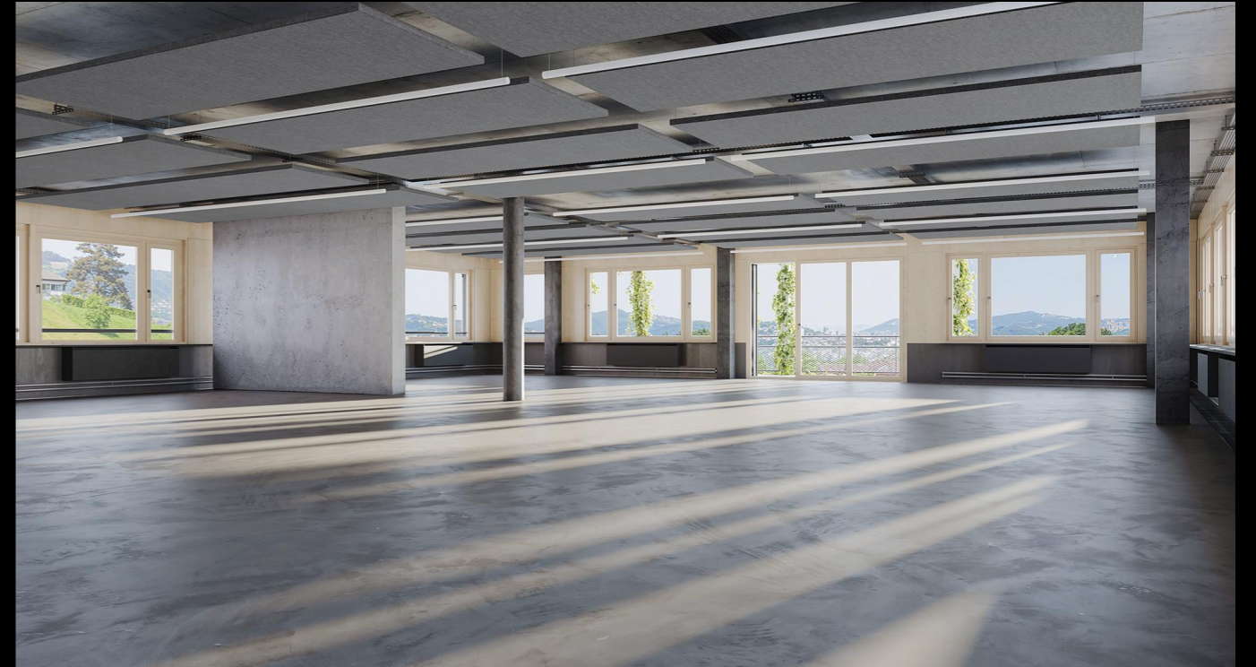
Edelrohbau mit Deckensegel / Blick auf begrünte Balkonfläche
