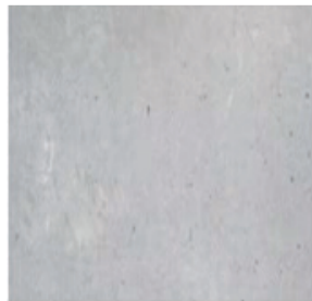
Decken Beton Typ 2, schalungsglatt
