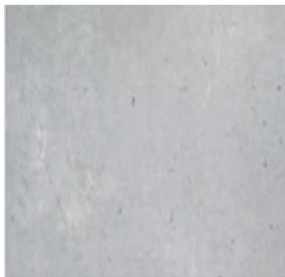
Wände Beton Typ 2, schalungsglatt
