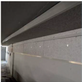
E-Mobility Vorbereitung Flachband an Wand und Lastmanagement für Montage Ladestationen (Kundenwunsch)
