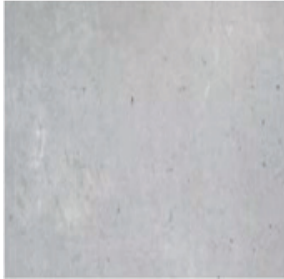
Wände Beton Typ 2, schalungsglatt
