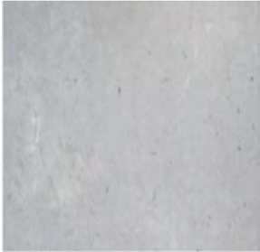
Decken Beton Typ 2, schalungsglatt
