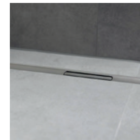
Dusche Boden Feinsteinzeug im Gefälle mit integrierter Rinne z.B. Geberit, Typ Cleanline30 Duschtrennwände in Klarglas
