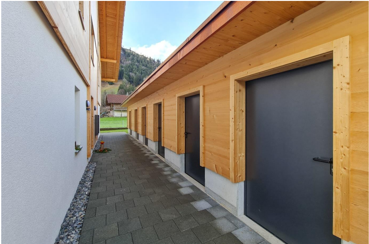
Der Nebenraum mit Licht und Stromanschluss... MUSTERFOTO
