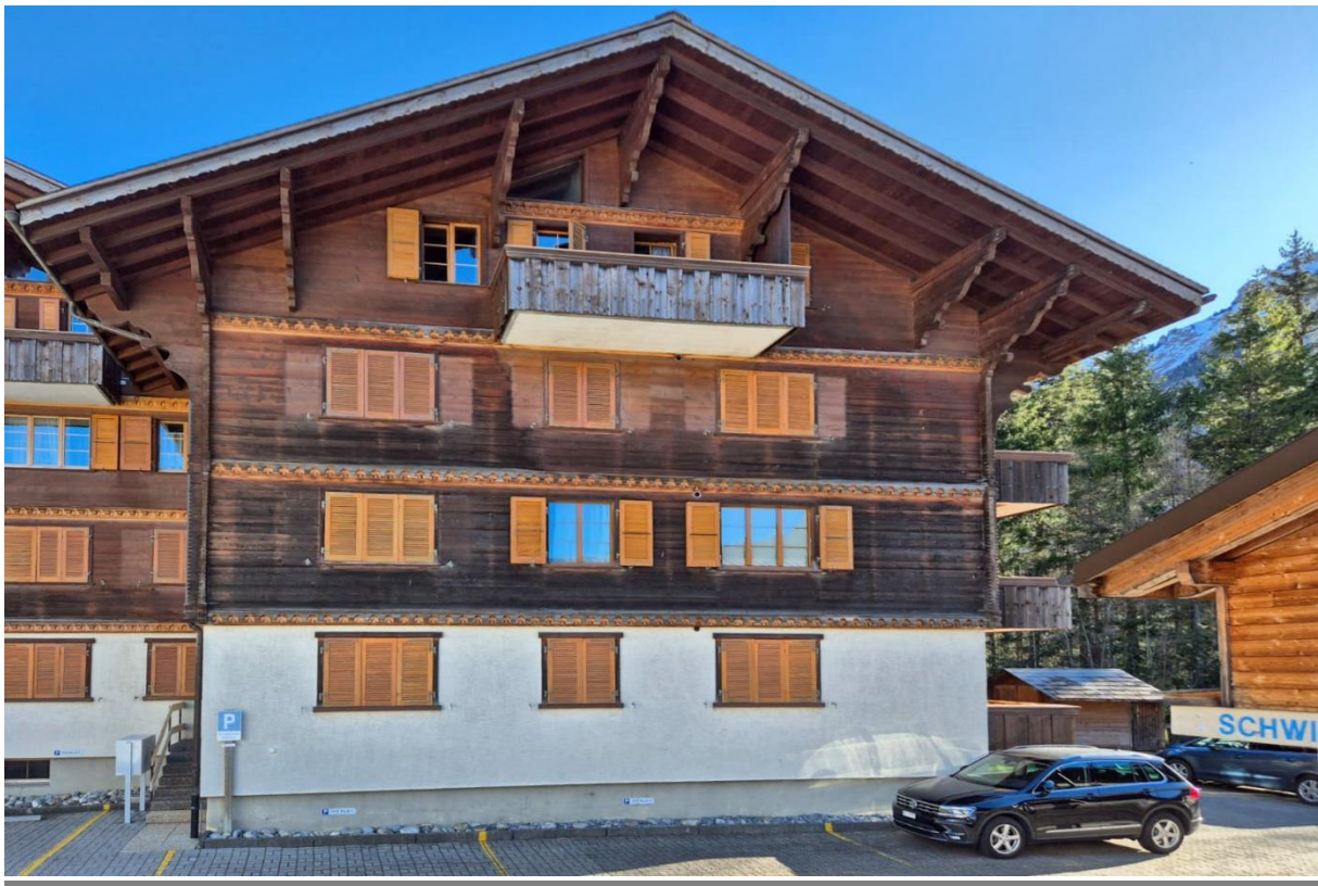
Die Aussenansichten mit dem Aussenparkplatz
