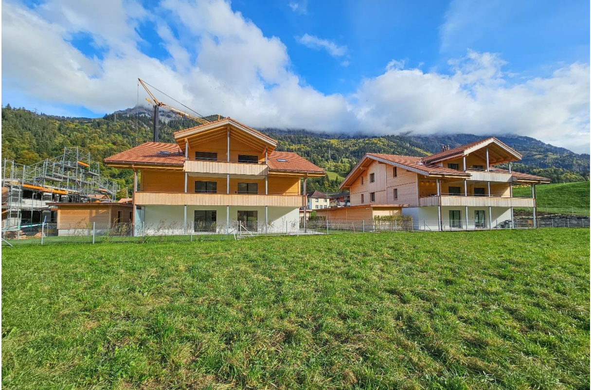
Das Haus Gehrihorn ist das Vierte von vier Mehrfamilienhäusern
