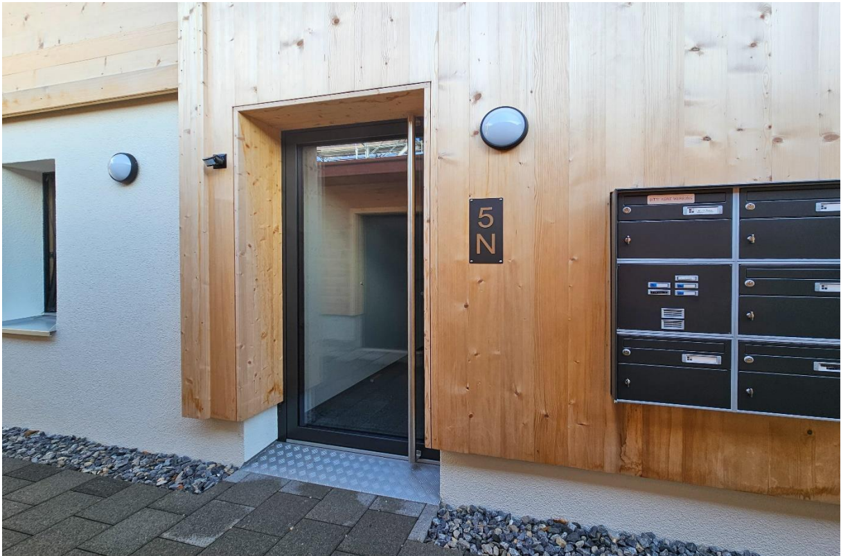
Der direkte Zugang über die Treppe zur Wohnung
