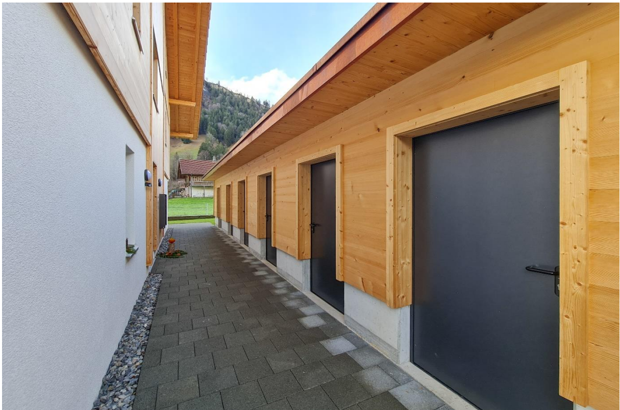
Der Nebenraum mit Licht und Stromanschluss...
