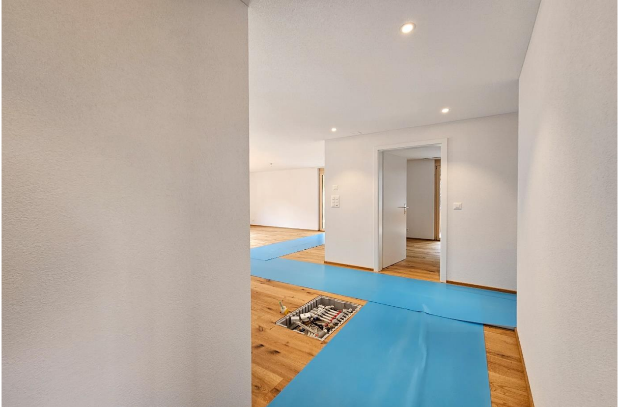
Der Eingangsbereich mit Garderobenschrank und Sonnerie (ist noch nicht fertiggestellt)
