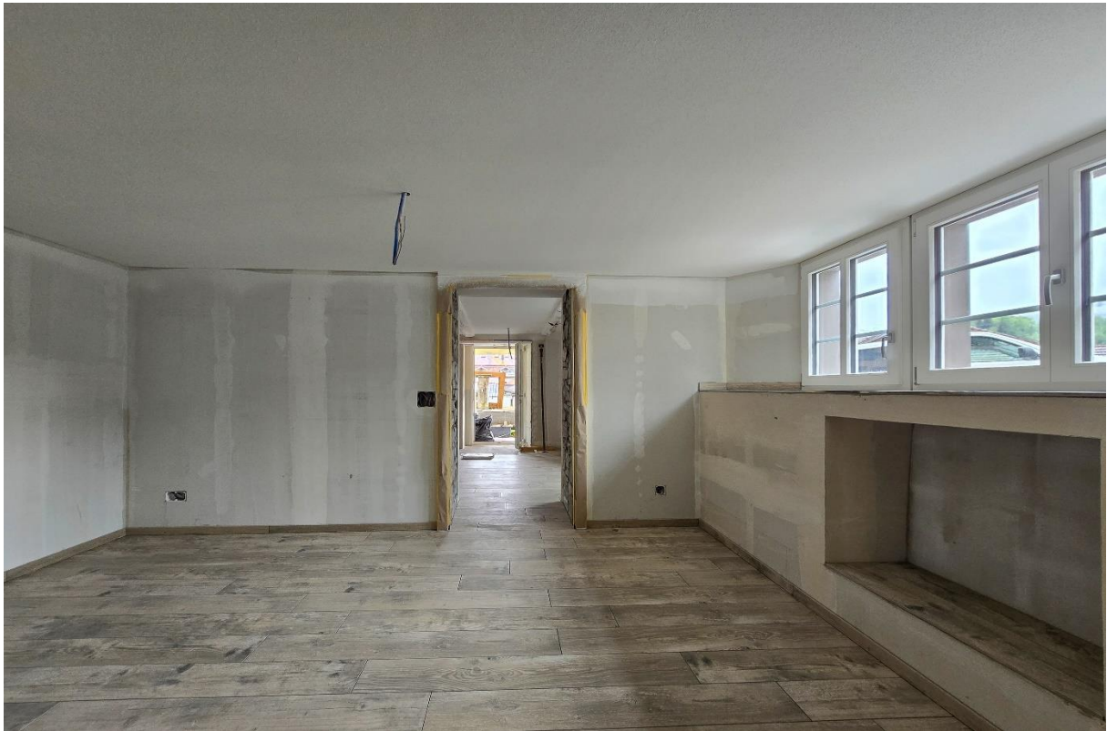
Blick vom Abstellraum Richtung Wohnungseingang
