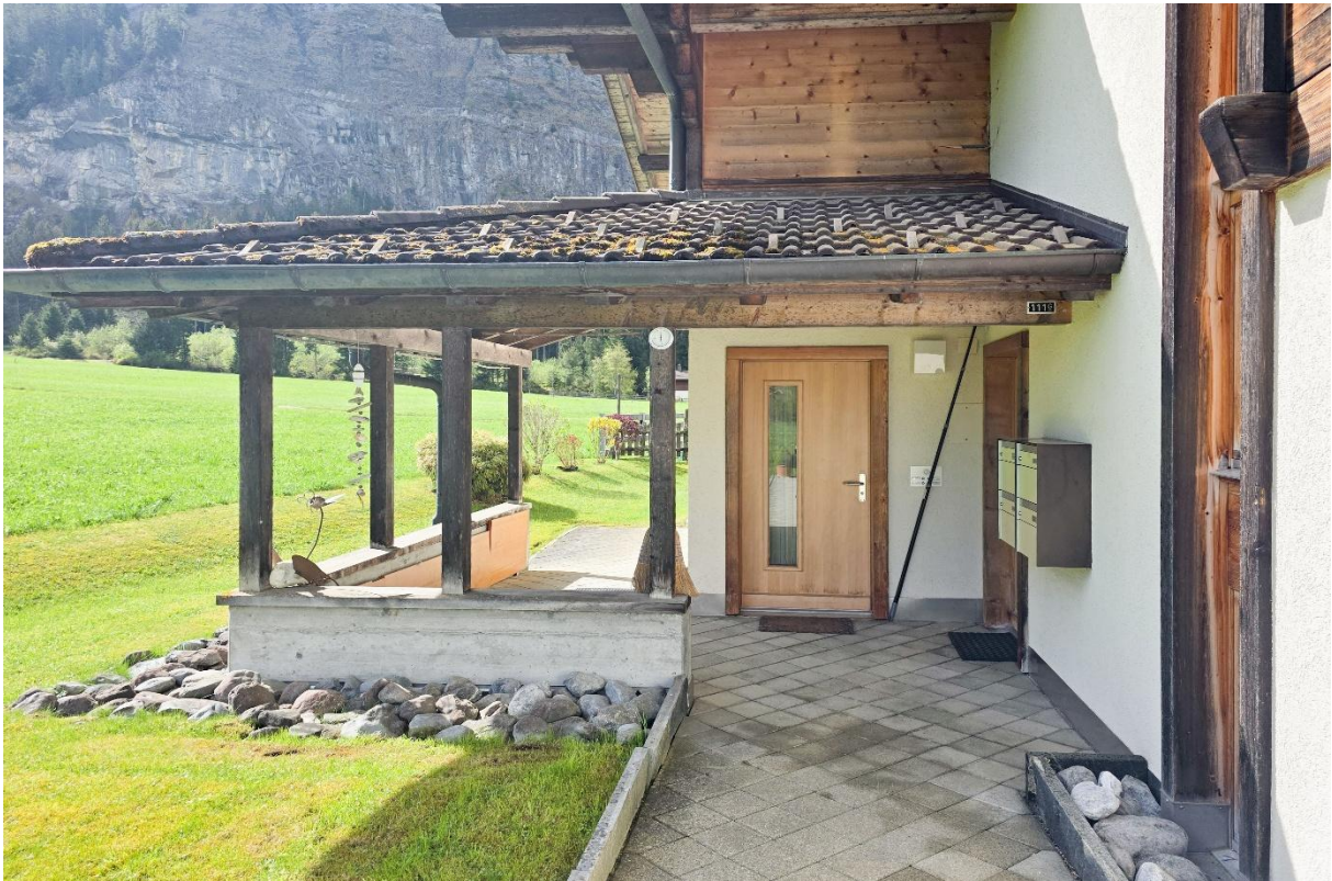
Der gedeckte Eingangsbereich in das Zweifamilienhaus
