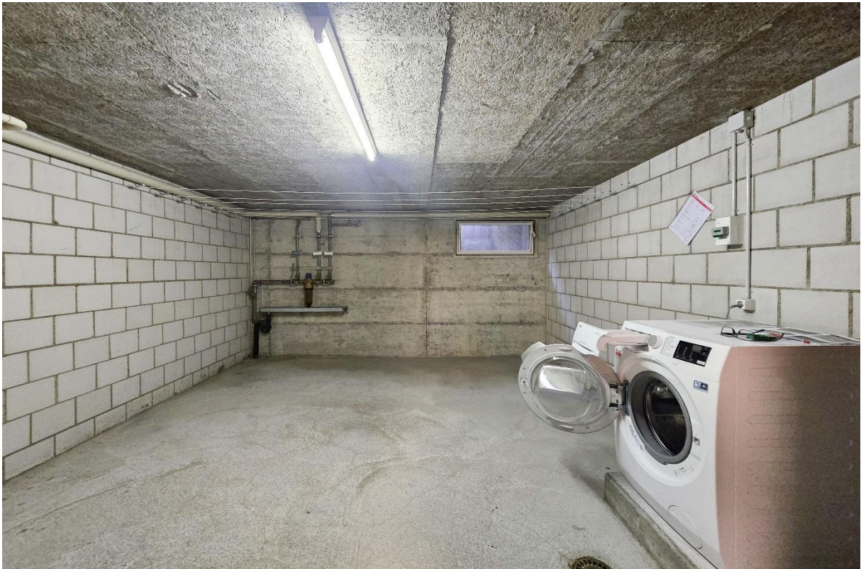
Die gemeinschaftliche Waschküche mit Waschmaschine und Hängevorrichtungen im Zweifamilienhaus
