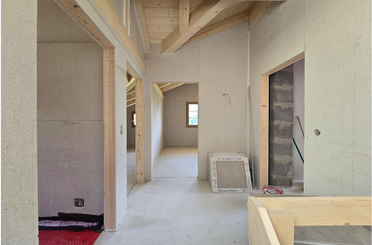
Die Treppe hoch gelangt man zu den Räumlichkeiten im Dachgeschoss
