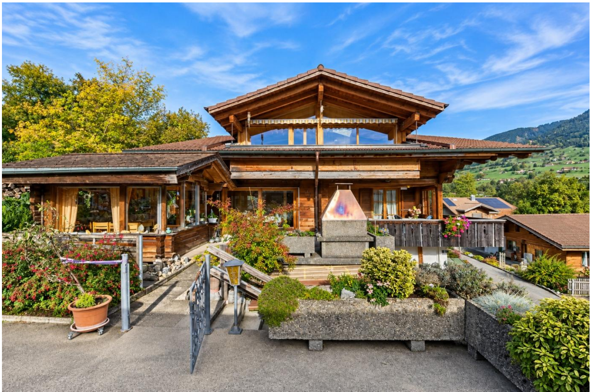
Die Aussenansicht des Wohnhauses mit der Zufahrt...
