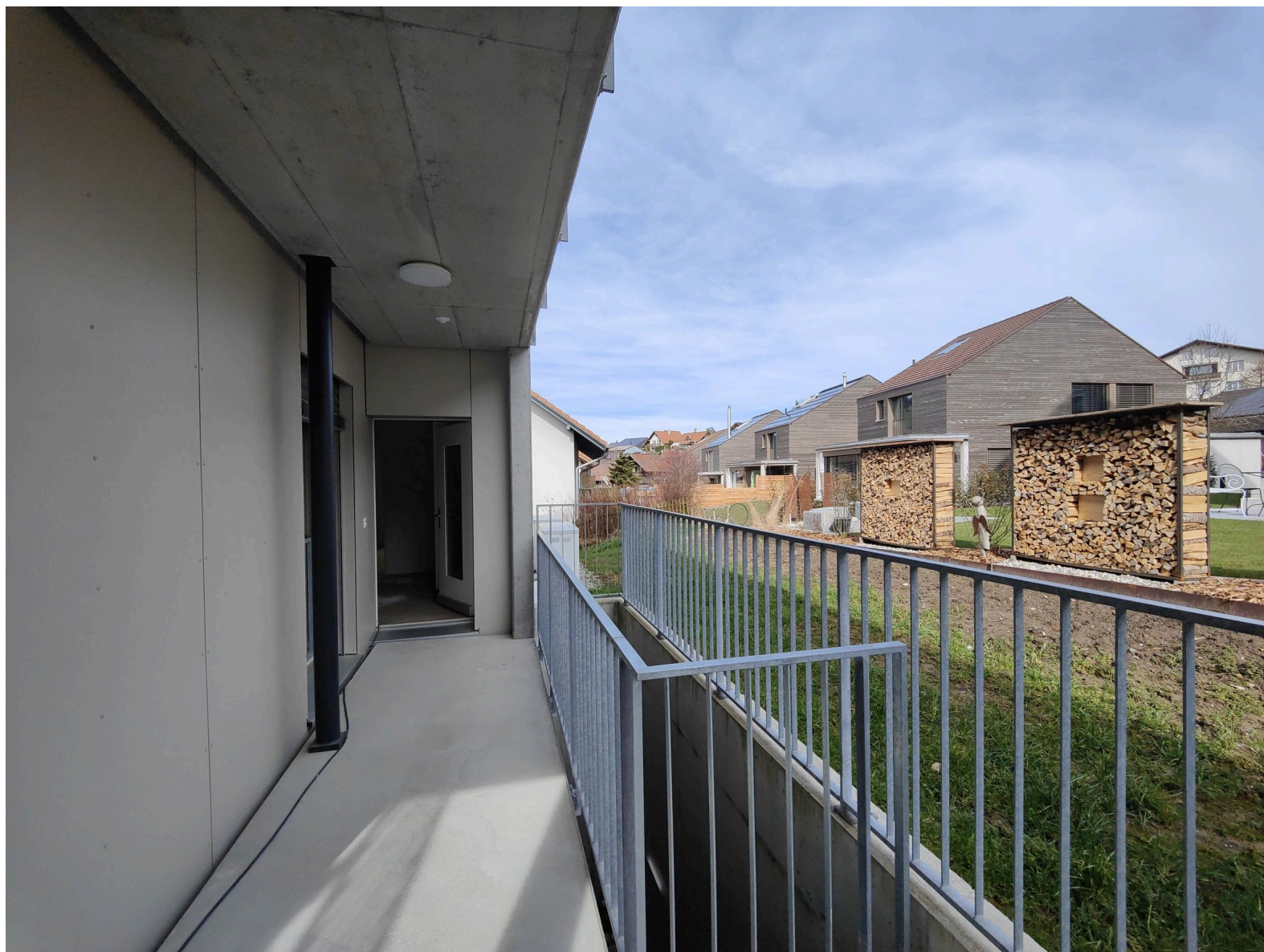
Lauben-Zugang Wohnung 2. OG
