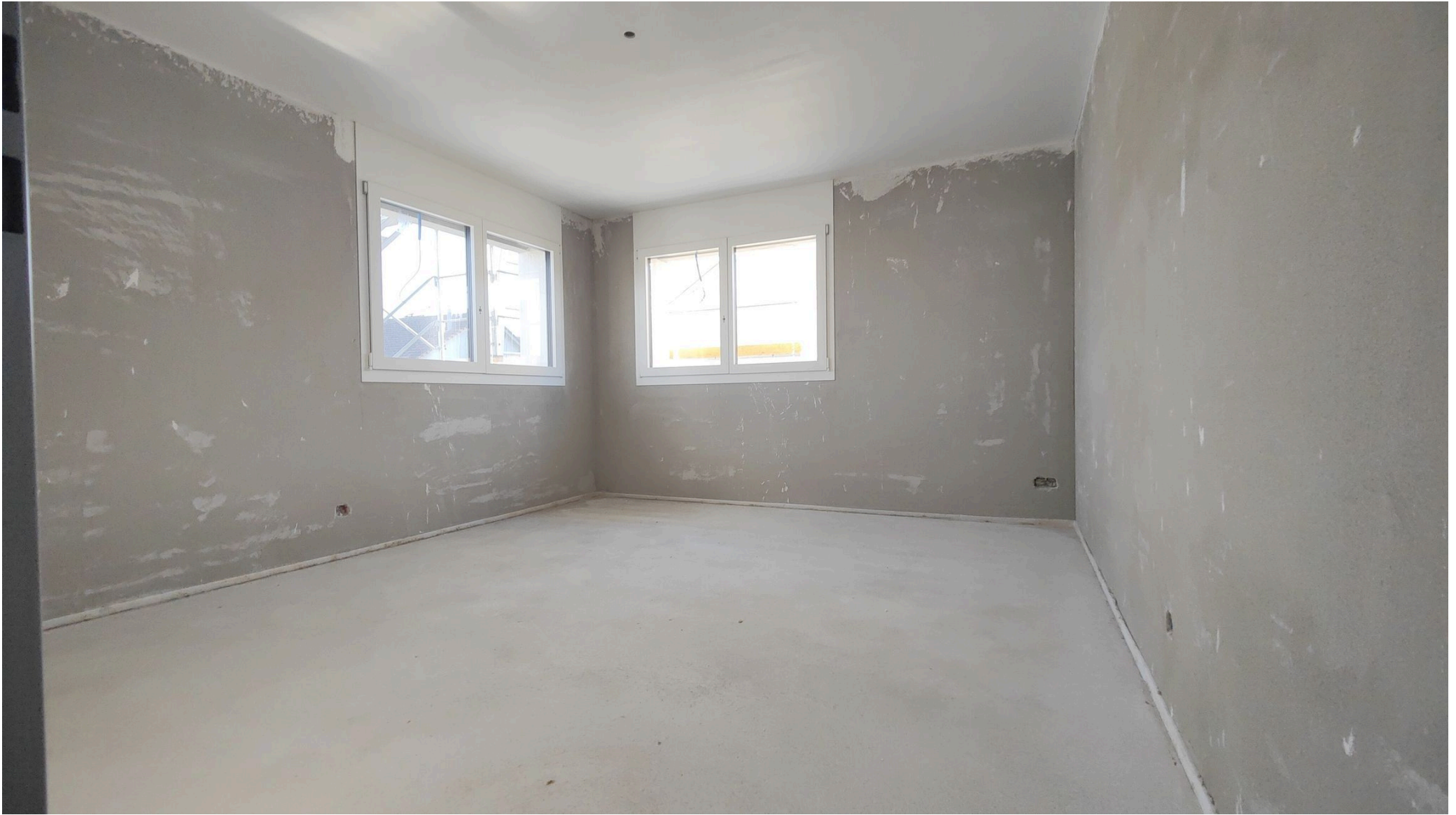
Das grosse Schlafzimmer entsteht (15.11.2023)
