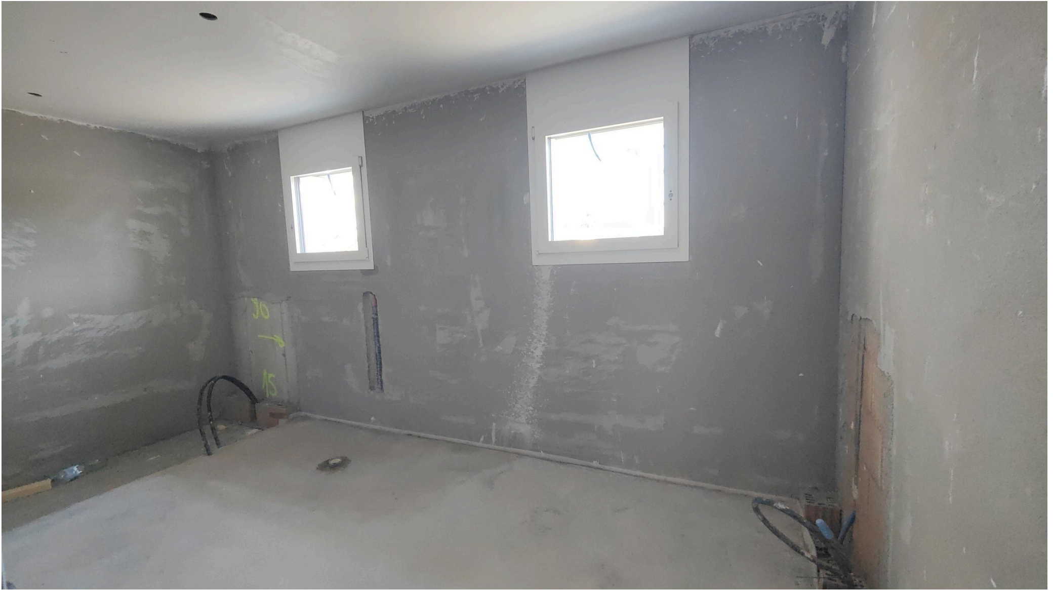
Hier entsteht das Traumbad mit Badewanne und Walk-In Dusche (15.11.2023)
