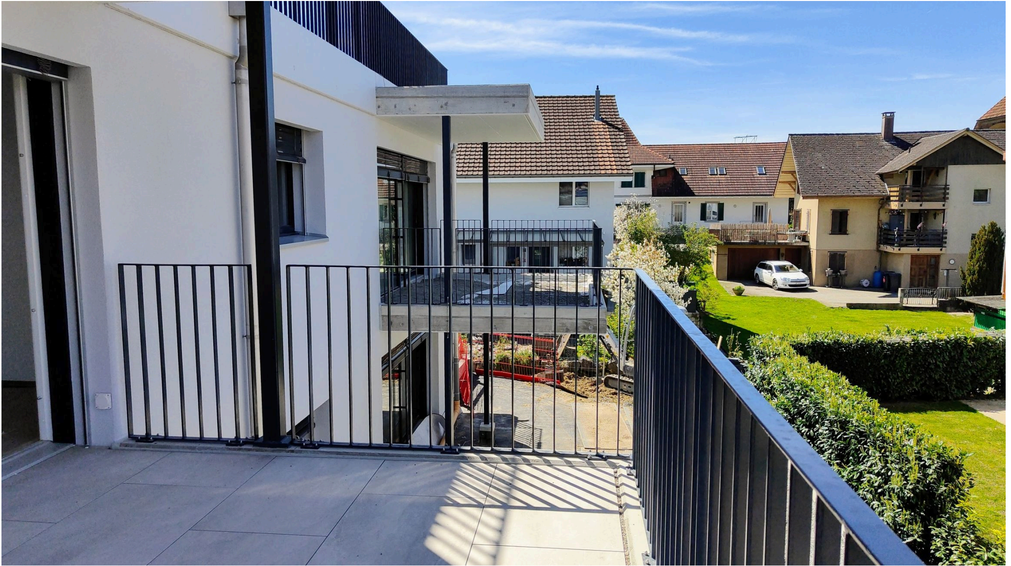
Blick vom gegenüberliegenden Balkon auf Balkon 2 (6.4.2024)
