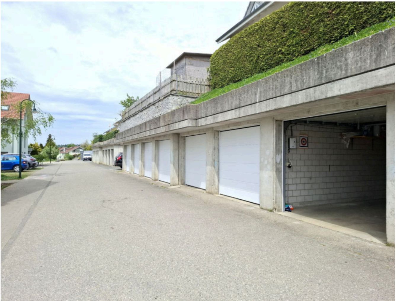
Die sieben Garagenboxen mit automatischen Garagentoren direkt neben dem Mehrfamilienhaus.
