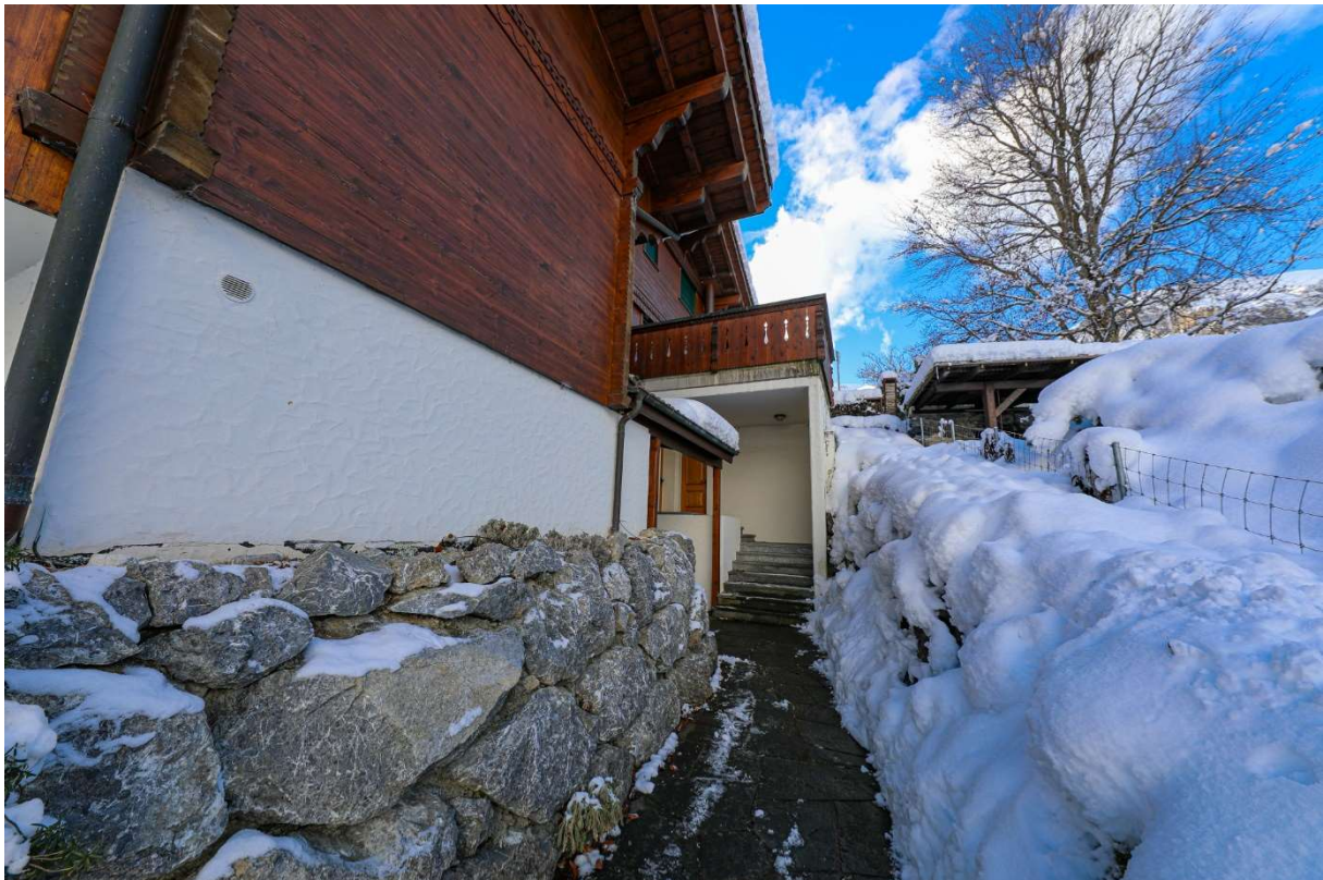
Der Eingangsbereich Über die Treppe erfolgt der Zugang zur Heizung, den Abstellraum
