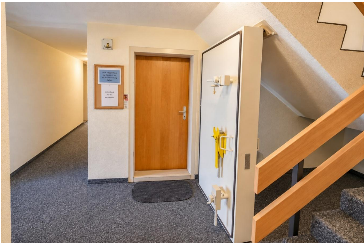
Der Zugang zum Keller
